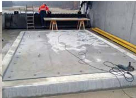
Überflutungssichere Abdeckung auf einer Montageöffnung, Ansicht von oben und von unten, Donaukraftwerk bei Augsburg
