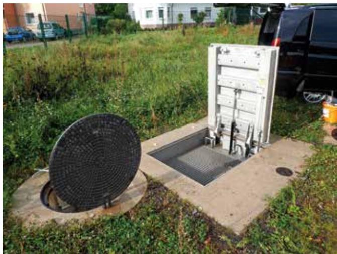
Kombination: runde Gussabdeckung mit Scharnier und Öffnungshilfe und Edelstahl-abdeckung mit Öffnungshilfe und Sicherheitsrost
