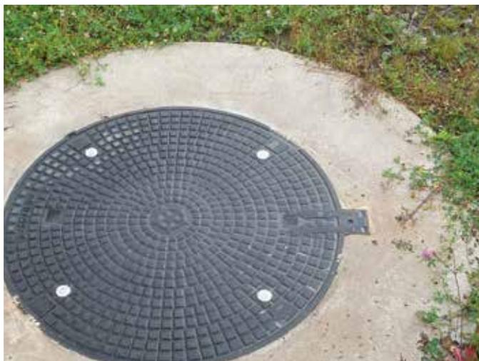
Rückstausichere Gussabdeckung mit Scharnier und Öffnungshilfe Belastungsklasse D400, lichte Weite 800 mm
