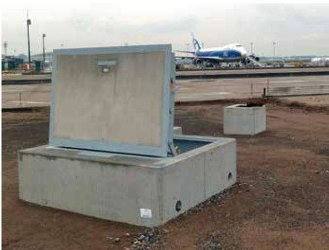
Hydraulisch betätigte Schwerlastabdeckung als Stahlbetonfertigteile, Belastungsklasse F900, Frankfurt
